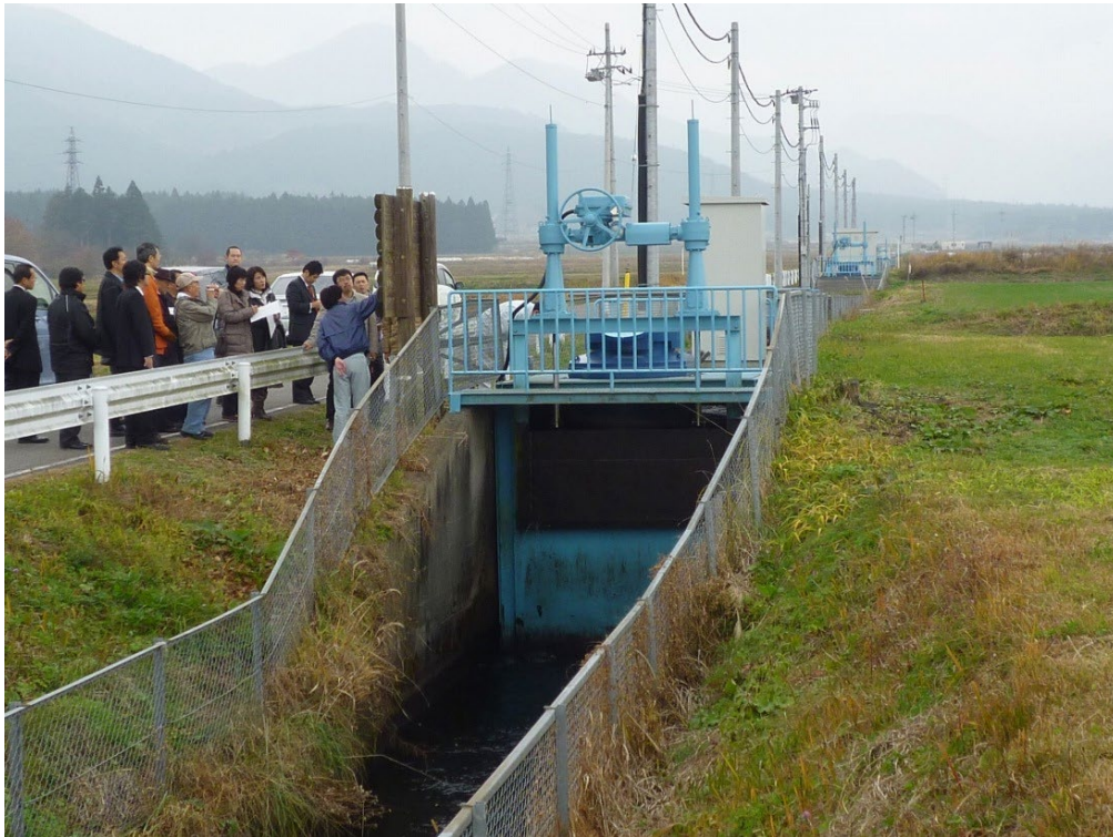
百村第一・第二発電所（栃木県那須塩原市） H=2.0\text{m} , Q=2.4\text{m}^3/\text{s} , P=30\text{kW} × 4
