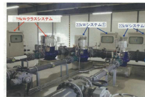
発電機室内のレイアウト・設置状況
