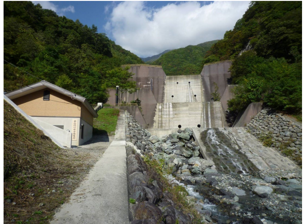
金山沢川水力発電所（山梨県南アルプス市） H=42.0\text{m} , Q=0.32\text{m}^3/\text{s} , P=100\text{kW}
