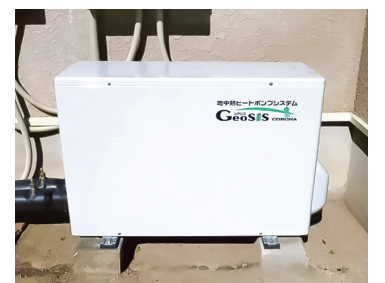
地中熱利用ヒートポンプ
