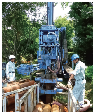
地中熱交換井の掘削状況
