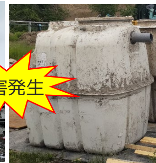
被災した浄化槽
