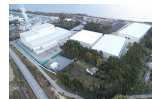
大熊町 仮設焼却施設
