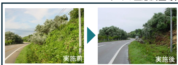
緩衝帯の整備
