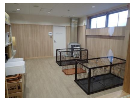
譲渡のための施設改修
