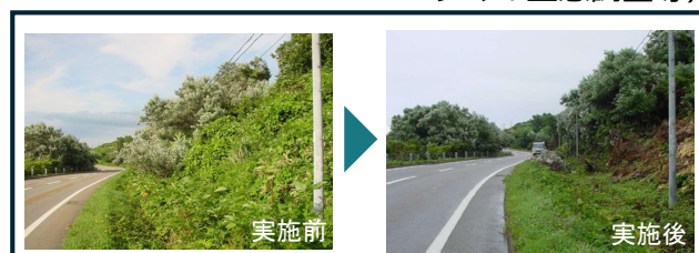
緩衝帯の整備
