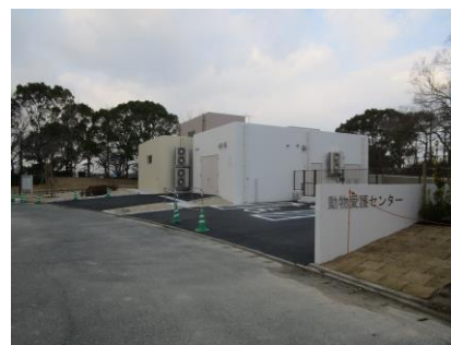
動物愛護センターの新築
