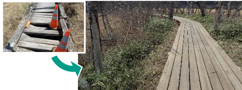
事例2 主要避難通路の再整備
