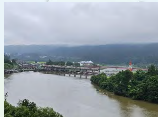
JR東日本 宮中取水ダム（十日町）
