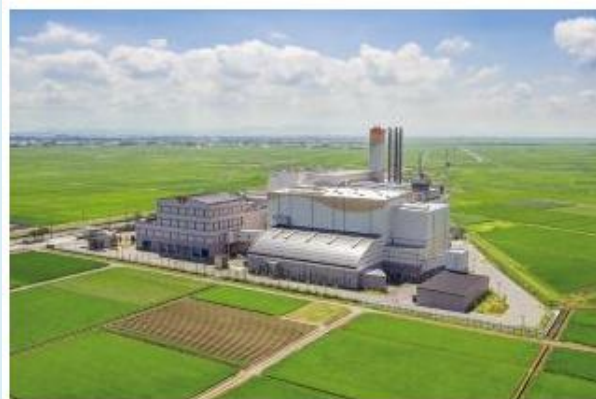
【電源一例】新田清掃センター(7,800kW)
