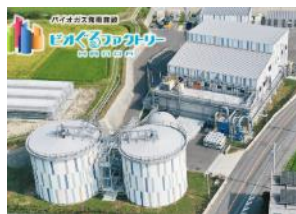
バイオガスプラント
