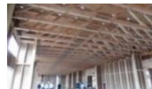
製材による大規模トラス
