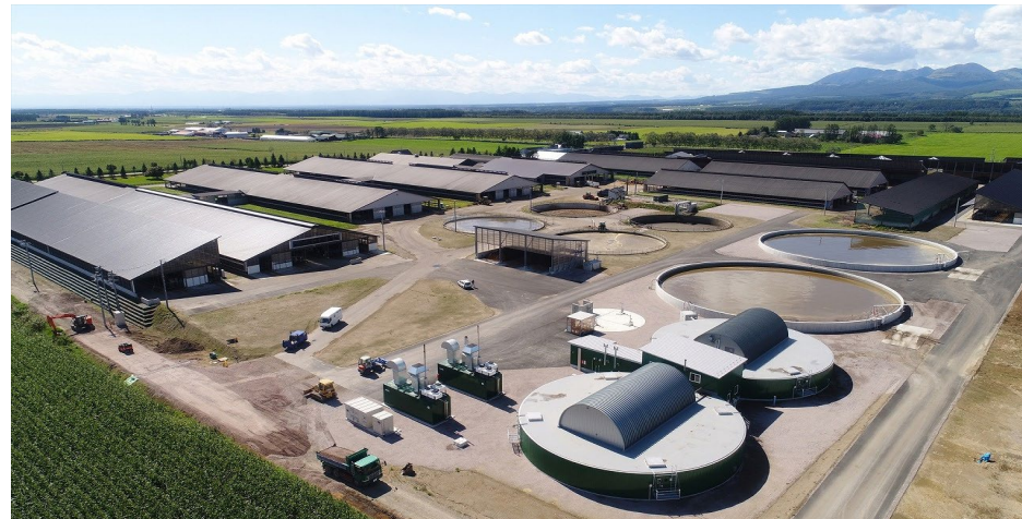
バイオガス 発電設備
