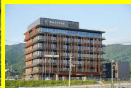
公共施設に電力供給
