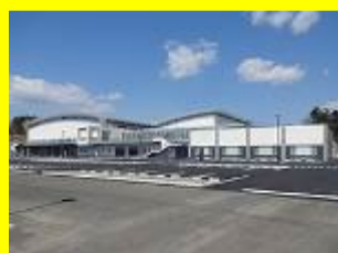
夢アリーナ太陽光と蓄電池
