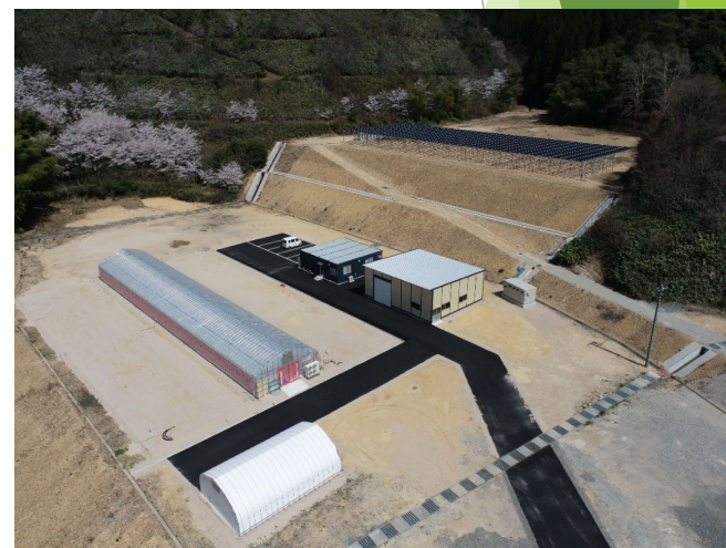
農業研修施設「みさと。トレーニングファーム」 （PV100kW、蓄電池50kWh）
