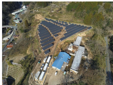
役場庁舎・防災センター太陽光発電設備 (PV500kW、蓄電池1.5MWh)
