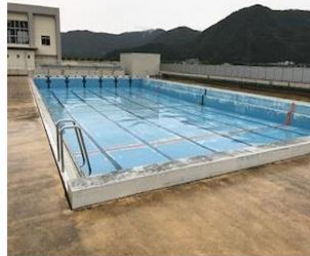
太陽光発電設備を設置予定の 小学校プール
