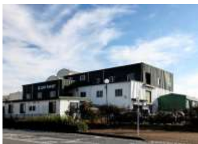
図 5-2 再生利用等施設の外観
