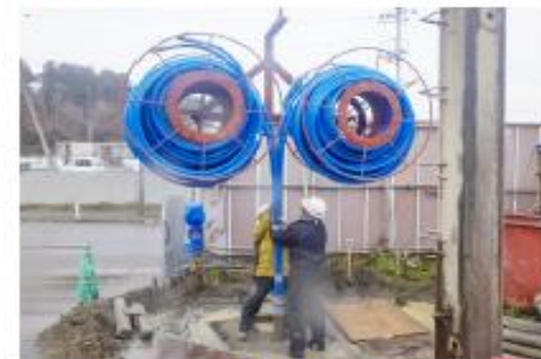
地中熱交換器の設置
