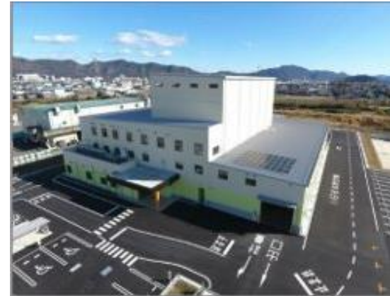
容器包装リサイクル推進施設
