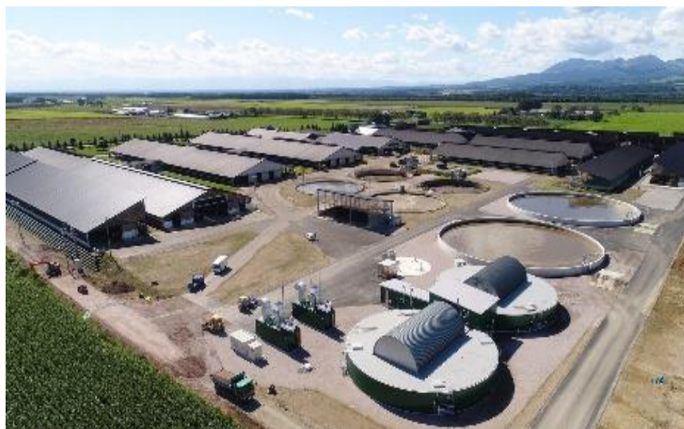
バイオガスプラント
