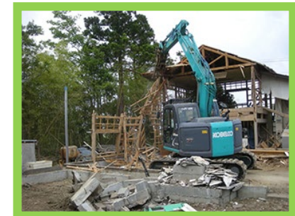
被災家屋等の解体
