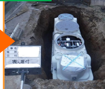
合併浄化槽設置
