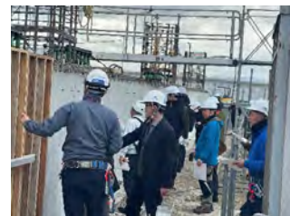
自社現場を活用した 国産材のトライアル
