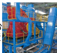
金属破碎・選別設備
