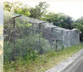
ノヤギ侵入防止柵
