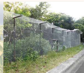
ノヤギ侵入防止柵
