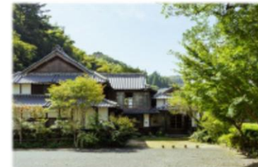
受入拠点の改修
