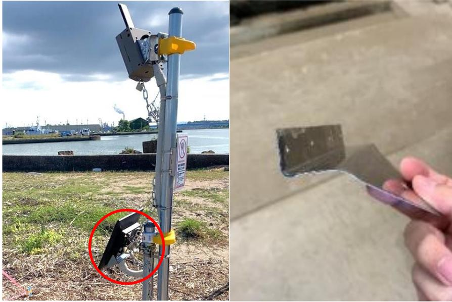
図 1.2.3 固定カメラの電源として設置されたソーラーパネルと、その台座となる鉄板部品（加工したもの）の例
