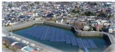
水上太陽光発電（埼玉県所沢市）
