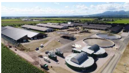
バイオガスプラント
