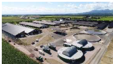
バイオガスプラント（北海道士幌町）
