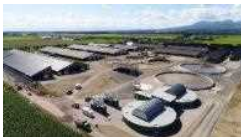
バイオガスプラント(北海道土幌町)
