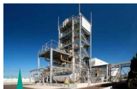
二酸化炭素分離回収設備
