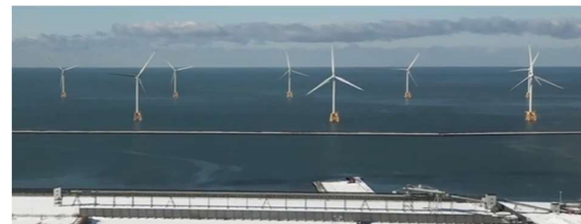
▲石狩湾新港洋上風力発電所(出所:株式会社グリーンパワーインベストメント WEBサイト)
