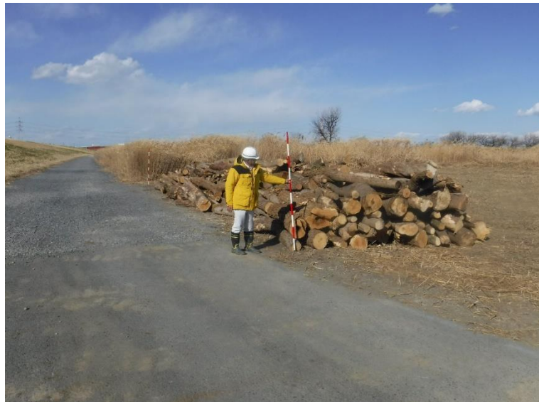
図 2.2.7 江戸川右岸 56.7km 付近の高水敷
