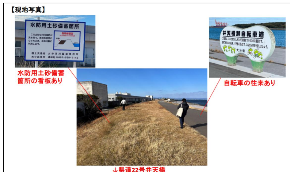
図 2.3.5 現地調査時の候補地の周辺状況
