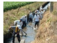
水路の泥上げ
