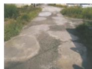
農道の窪みの補修
