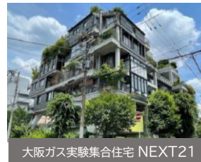
大阪ガス実験集合住宅 NEXT21
