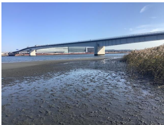
写真 1 完成した多摩川スカイブリッジ
