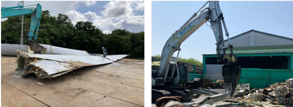
図 2-10 風力発電ブレードの解体の様子
