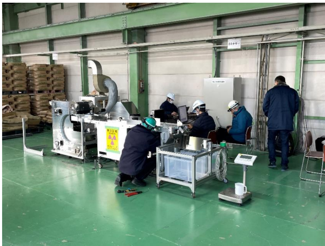
図 2-3-8 工事状況写真
