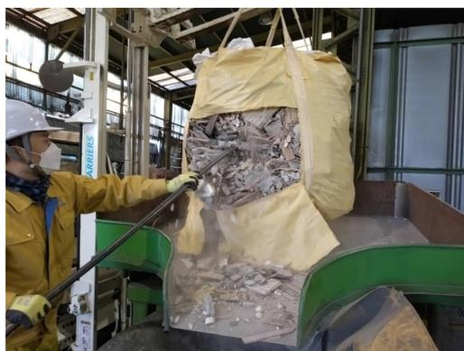
図6.2 フレコンに入った建設系混合廃棄物をコンベアに流しながら分別を行う
