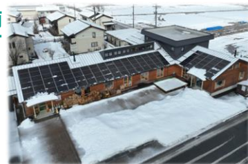
融雪機能付き太陽光パネル
