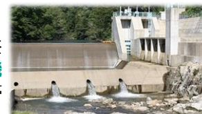
町営小水力発電所
