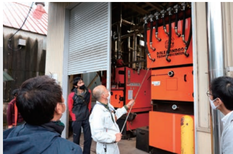
木質バイオマス発電施設の見学
