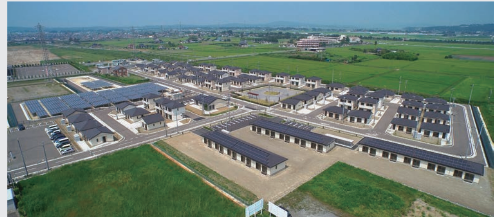
東松島市スマート防災エコタウン
