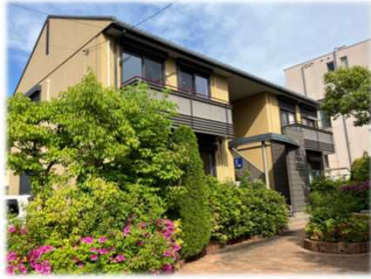
断熱改修を行う 既存賃貸集合住宅
