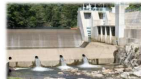
町営小水力発電所
