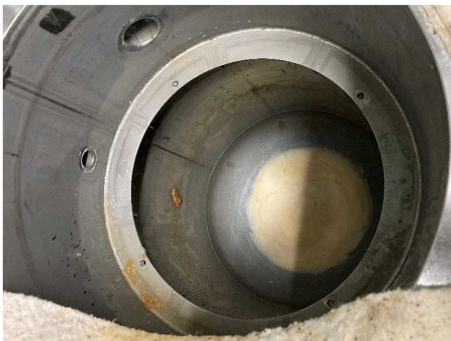
図. 24 溶解槽内の様子
