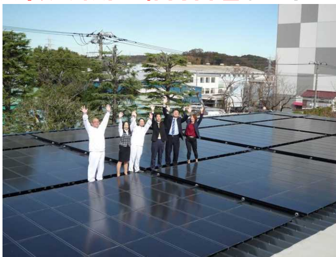
株式会社大川印刷の工場に 設置された太陽光発電
