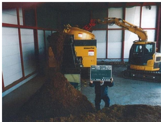
搬出した被害木のチップ化作業
