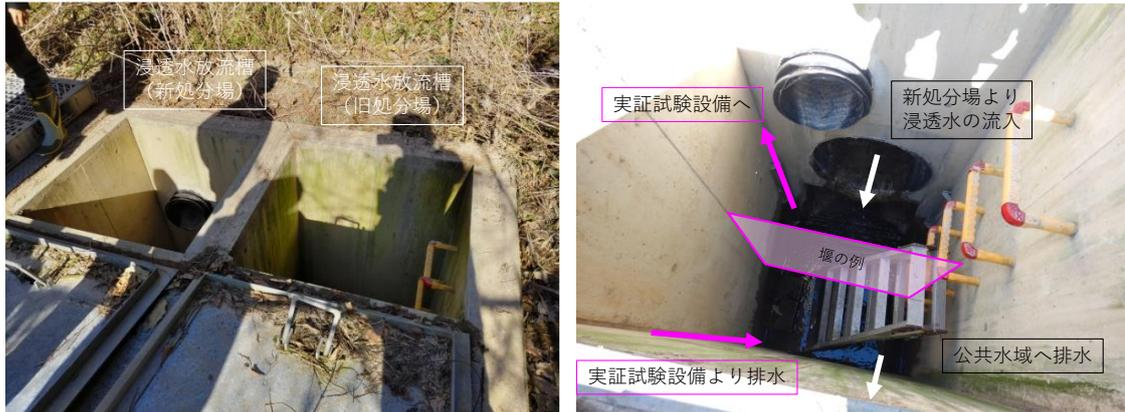
図 浸透水放流槽の詳細
