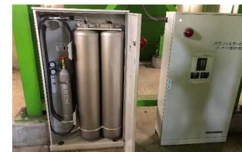
汎用品により作成されたバグフィルター消火装置
