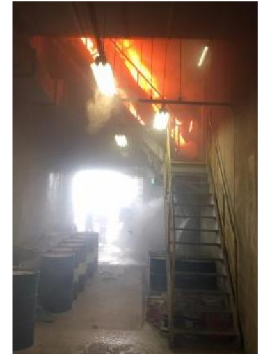
令和2年に発生した大規模火災で下図の搬送コンベヤが燃焼
