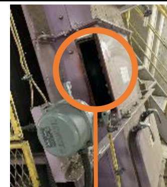
直接消火が行いづらいコンベヤ部分に、新たに消火用の穴を複数設けた
