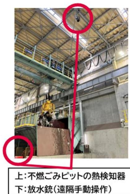
図 4-31 不燃ごみピットの上部に設置された熱検知器と放水銃
