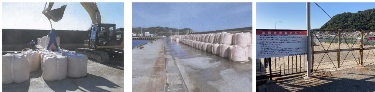
図 1-4 仮置き土設置状況（左：工事状況、中：設置後、右：フェンス）
