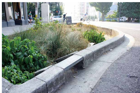
図4 ポートランド市内のバイオスウェイル
