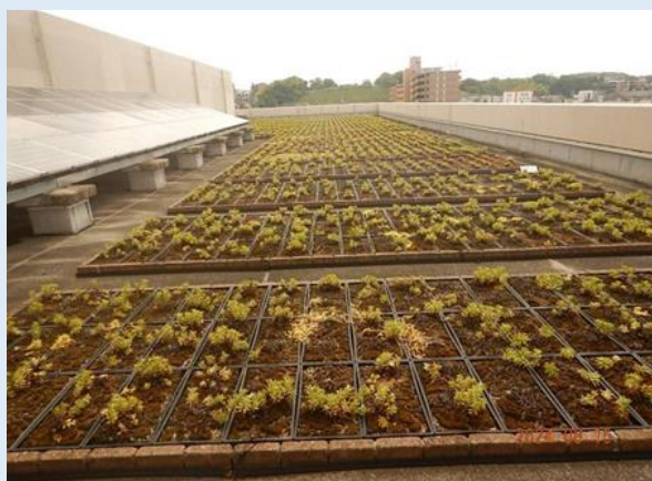
施設の屋上緑化及び太陽光パネルの設置 （プラットホーム屋上）
