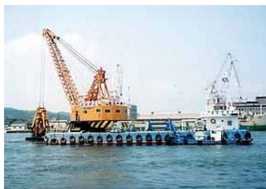
(グラブ浚渫：水深が深い場合)
