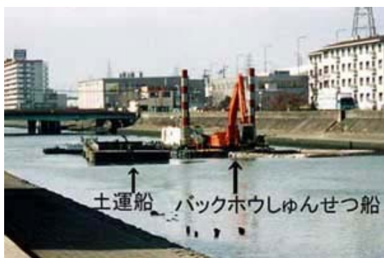
(バックホウ浚渫：水深が浅い場合)
